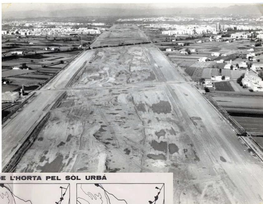
Construcció del Plan Sur (dècada 1960s) Font: AVV Castellar-L'Oliveral
